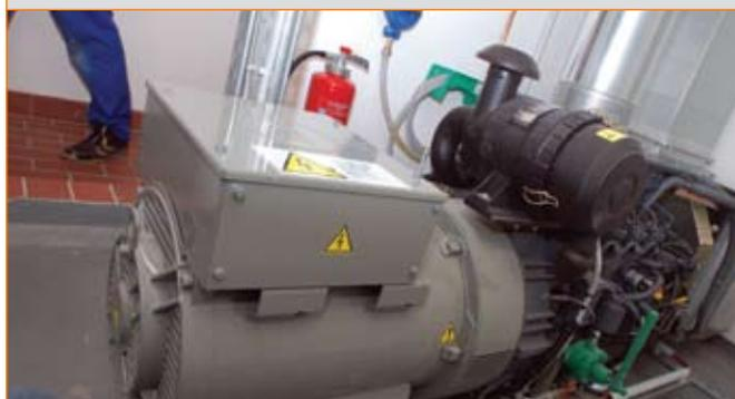
Das Notstromaggregat sorgt dafür, dass auch dann Strom fließt, wenn das öffentliche Netz versagt.
